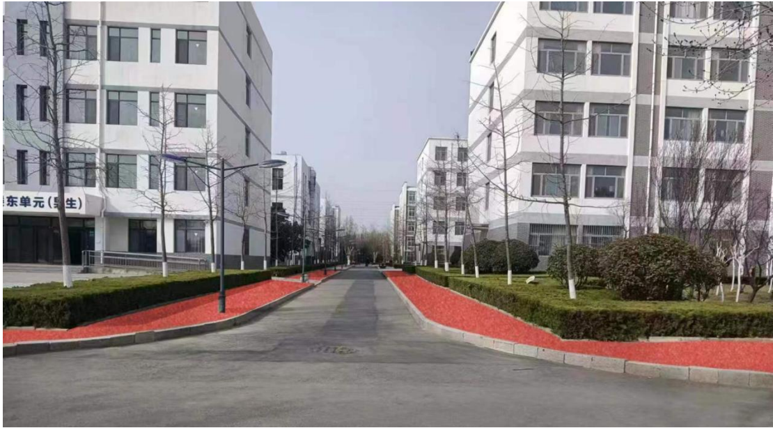
图 6-15 改造提升后的宿舍区步行道
